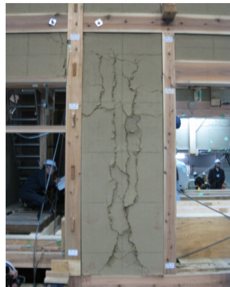
1階 七通り、ち～り 土壁のひび割れ
