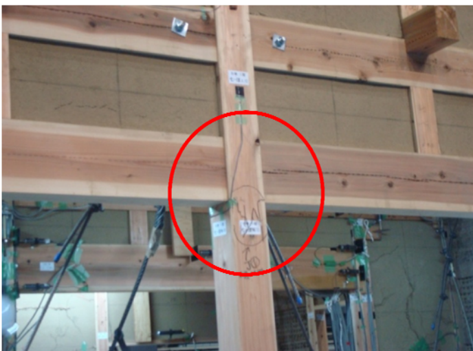
1階 七通り、ほ 差し鴨居部分の柱の曲げ破壊
