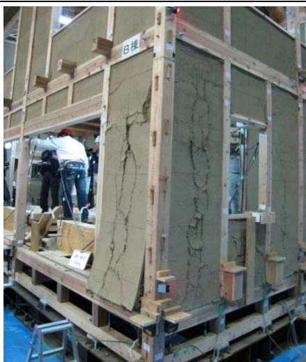
1階 七通り、い～ろ 土壁のひび割れとめくり上がり
