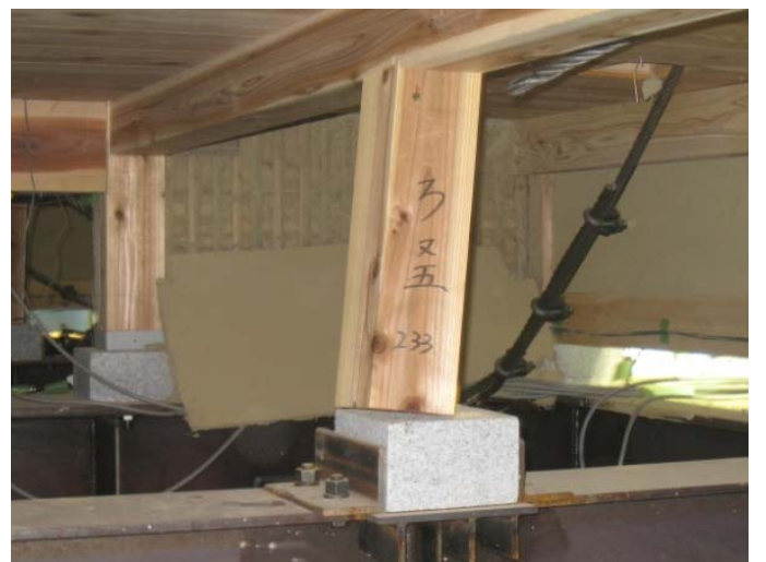
1階 ろ通り、又五 東石と束のずれ
