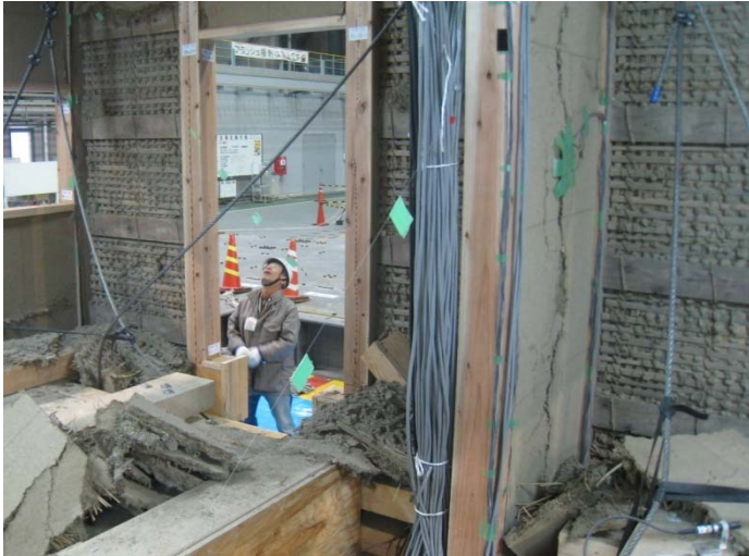
1階 い通り、巻～四 室内側の土壁の剥落
