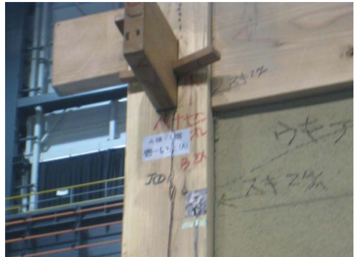
1階桁 い通り、壱 接合部の鼻栓折れ及び柱の割れ
