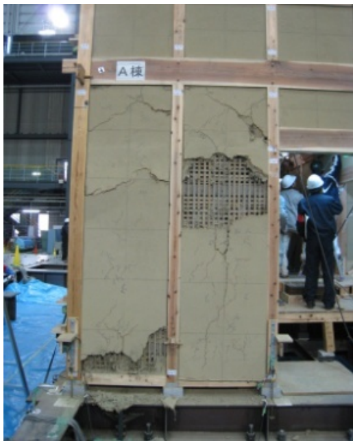
1階 七通り、る～わ 土壁のひび割れと剥落
