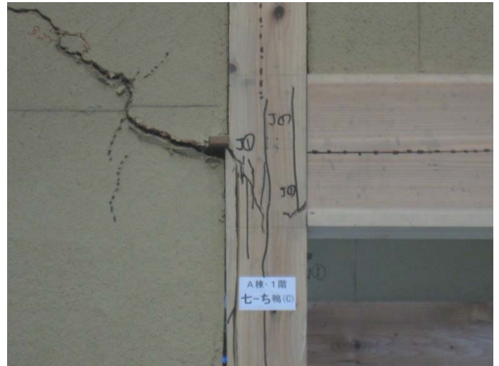
1階 七通り、ち 差し鴨居部分の柱の割れ
