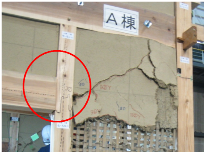
1階桁 七通り、ろ 差し鴨居部分の柱の割れ
