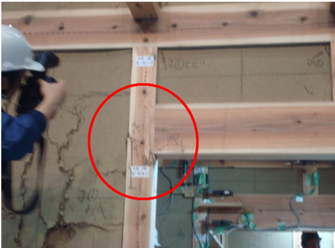
1階 七通り、ち 差し鴨居部分の柱の曲げ破壊
