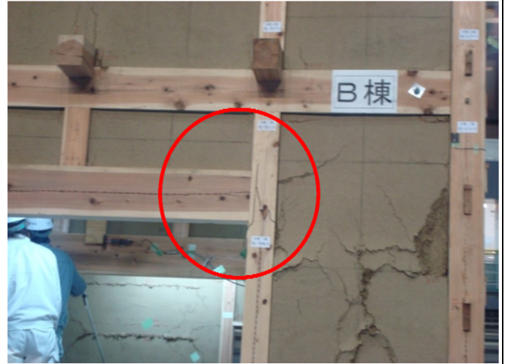
1階 七通り、ろ 差し鴨居部分の柱の曲げ破壊
