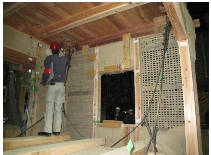
1階 い通り、四～七 室内側の土壁の剥落
