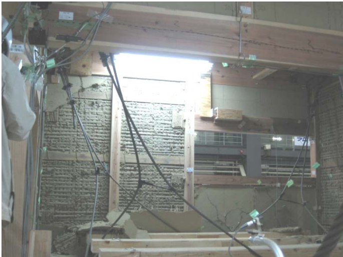
1階 壱通り、い～ほ 室内側の壁土壁のひび割れと剥落
