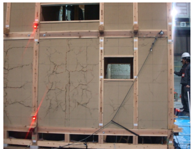
1階 壱通り、り～わ 土壁のひび割れ
